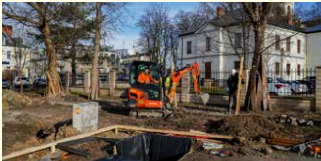
Pierwszy etap zazieleniania centrum Kielce rozpoczął się na ul. Bodzentyńskiej. Wykonawca prowadzi roboty ziemne pod przyszłe nasadzenia i budowę małej architektury.
