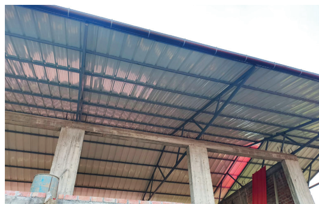
Nowowytbudowany dach szkoły parafialnej.
