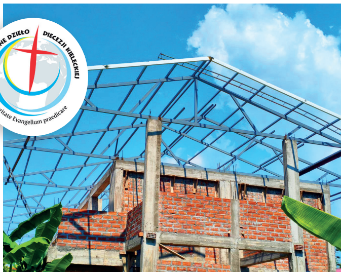
Trwająca budowa szkoły parafialnej.
